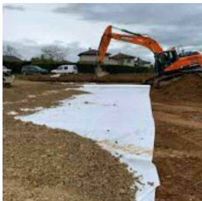
Opérations de remblaiement
