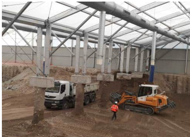
Excavations sous tente – fermes portées par micropieux
