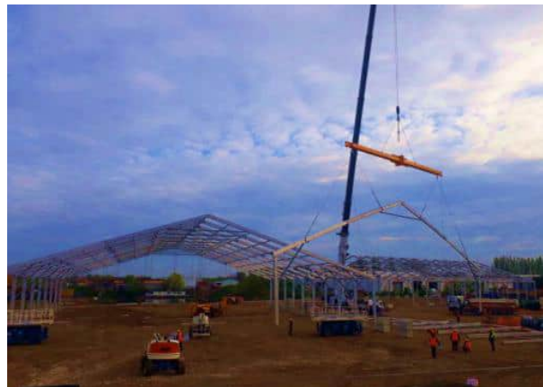
Opération de montage d'une tente – grutage des fermes
