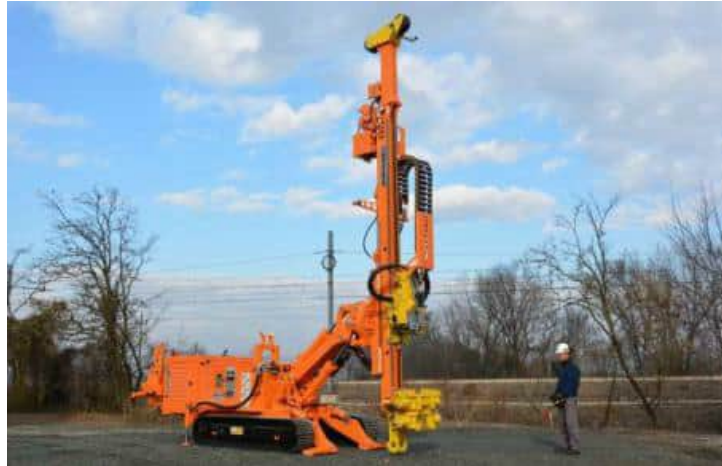
Opération de forage de micropieux
