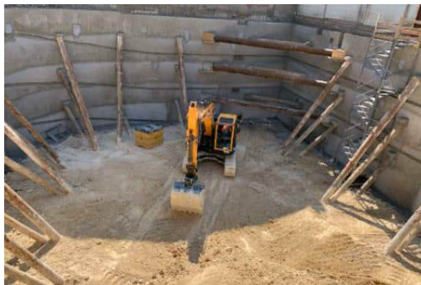
Confortement par voile par passes et buton de soutènement
