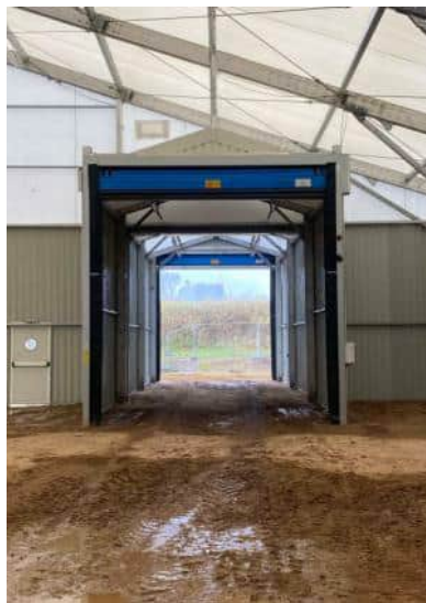
Vue d'un sas de tente de confinement
